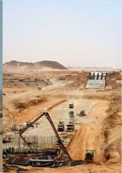
إحدى الترع تحت الإنشاء
